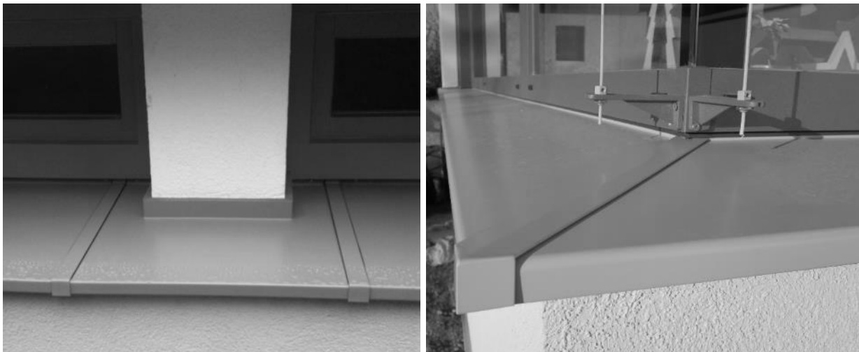
Abbildung 8: Fensterbank mit Stoßverbinder und Eckausführung
